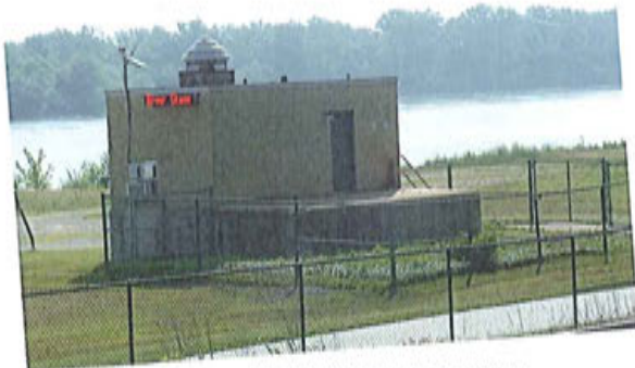
Walnut Street Liftstation 2011
